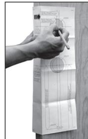
A. Marcar los orificios de los barrenos a y b, a1 y b1.
